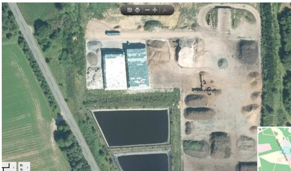
Figur 1 Oplags- og behandlingsområde. Orthofoto er fra 2016, og balleoplaget har da en udstrækning på knap 40 x 40 meter. Andre typer oplag er fjernet fra pladsen i dag. Nederst ses perkolatlaguer.
